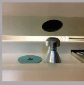
Nokker i dørens bagkant, som griber ind i stål-karm
